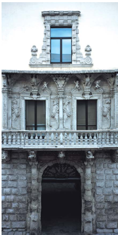
Facciata principale di Palazzo della Marra. (foto di Pierluigi Siena) The main facade of Palazzo della Marra. (photo by Pierluigi Siena)
